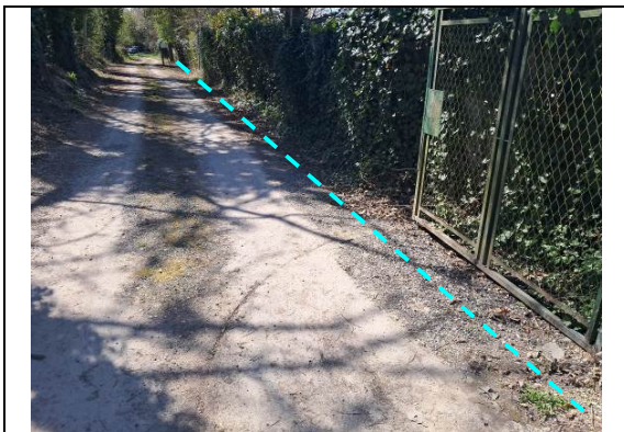
GC Tradi Terrain Naturel 3 PVC Ø42/45 et plynnox + Remblai GNT (Attention réseaux privés existants non apparents sur DT)
