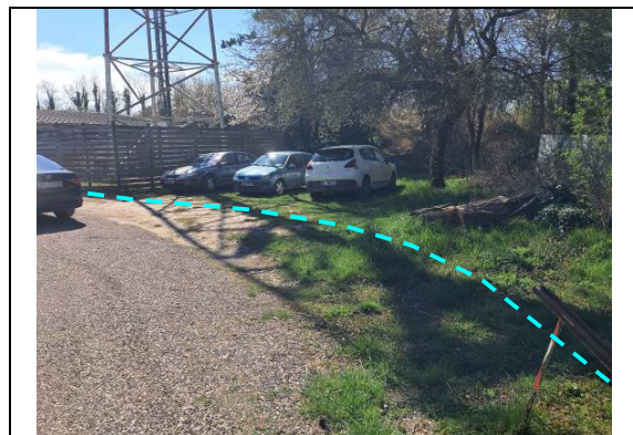
GC Tradi Terrain Naturel 3 PVC Ø42/45 et plynnox + Remblai GNT (Attention réseaux privés existants non apparents sur DT)
