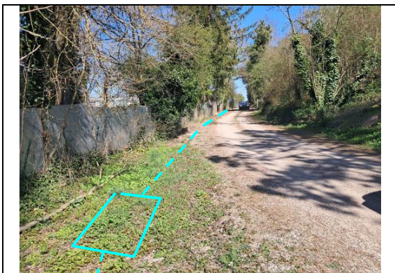
GC Tradi Terrain Naturel 3 PVC Ø42/45 et plynnox + Remblai GNT + Pose d'une chambre L2T FREE (Attention réseaux privés existants non apparents sur DT)
