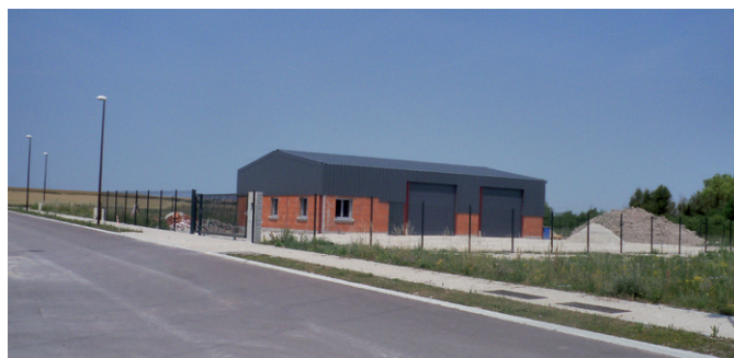
MS Construction maçonnerie
