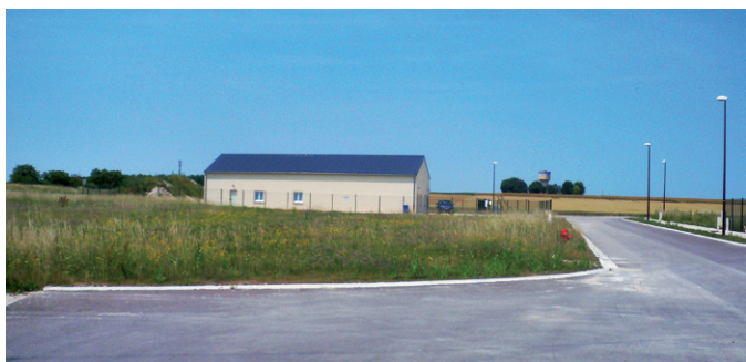
CH Calorifuge travaux de plomberie
